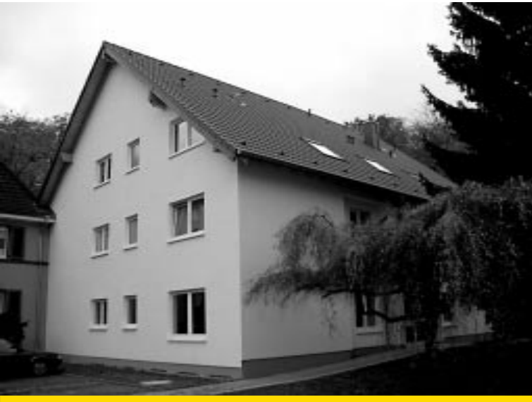
Der Neubau in der Reuschenberger Straße
