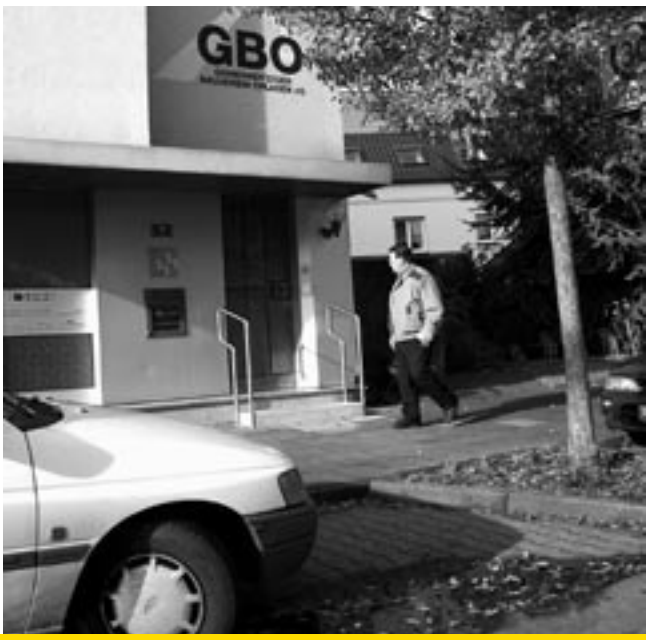
Eine neue Treppe erleichtert den Zugang zum Bauverein.
