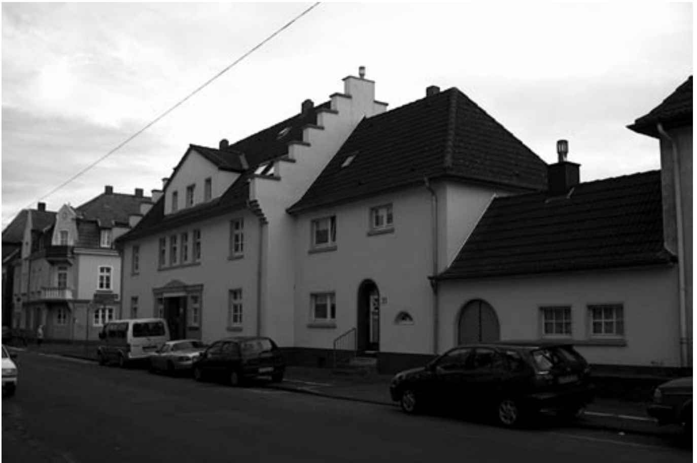
Feuerwehrsiedlung: Die Fortführung der Sanierung der Feuerwehrsiedlung ist für das zweite Quartal 2003 geplant.
