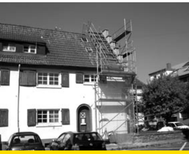
Gut vorangeschritten: die Sanierungsmaßnahmen in der Feuerwehrsiedlung
