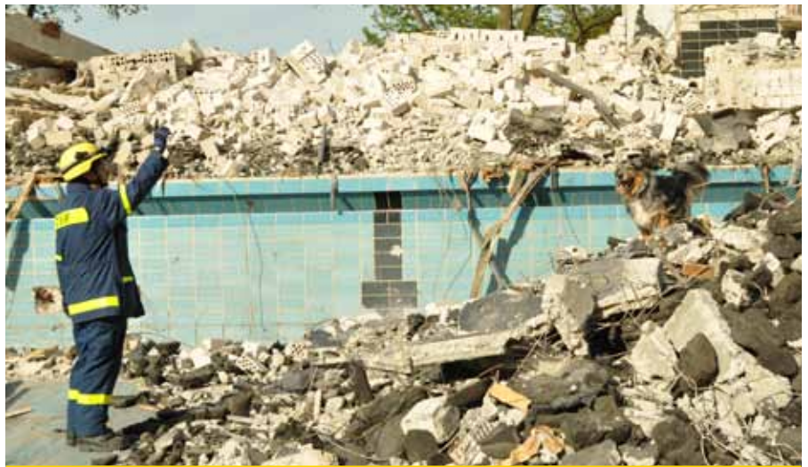
Das Technische Hilfswerk führte auf dem Abrissgrundstück eine Übung durch.
