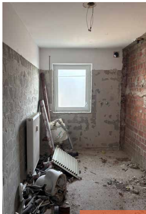
Kernsaniierung der Küchen und Badezimmer 2026 für umfassende Erneuerung der Zu- und Abwasserleitungen
