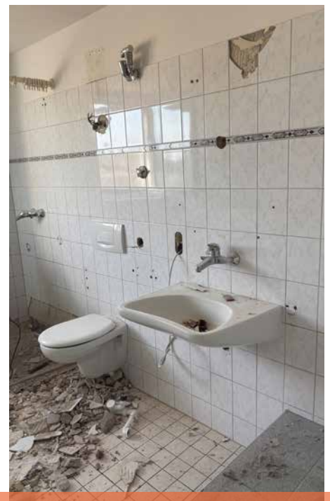
Kernsaniierung der Küchen und Badezimmer 2026 für umfassende Erneuerung der Zu- und Abwasserleitungen
