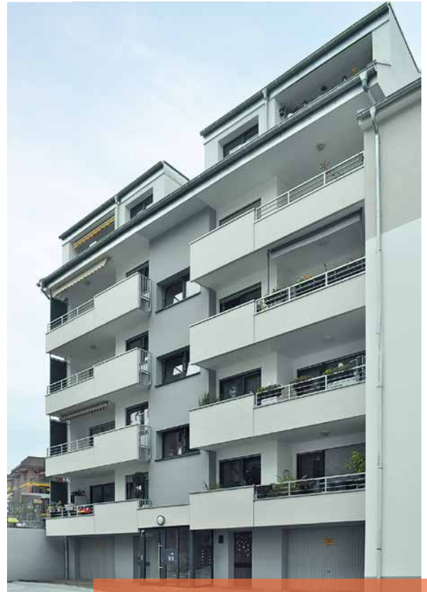
Mittelstraße 31 nach der Sanierung 2024
